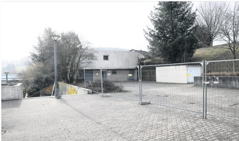
Noch steht hier das ehemalige Hausmeisterhäuschen, doch schon in der kommenden Woche wird es abgerissen. Damit wird Platz geschaffen für den 38 Meter langen und 15 Meter breiten Neubau am Überwald-Gymnasium. Hier sollen zum neuen Schuljahr zwölf neue Klassenräume entstehen.
